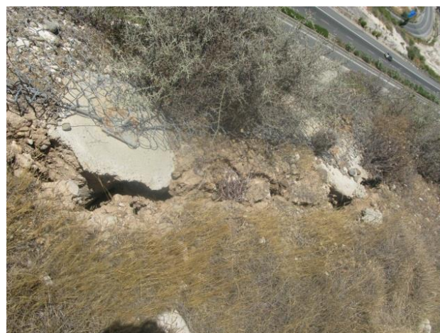
Εργασίες προσωρινής αποκατάστασης της αστάθειας στη τελευταία αναβαθμίδα του μεγάλου πρανούς παρά τη γέφυρα Πισσουρίου με βάση την εκπόνηση της γεωλογικής έρευνας από το Τμήμα Γεωλογικής Επισκόπησης Temporary remedial works at the big slope of the Highway near Pissouri bridge. The geological studies will continue on to the next highway slope.
