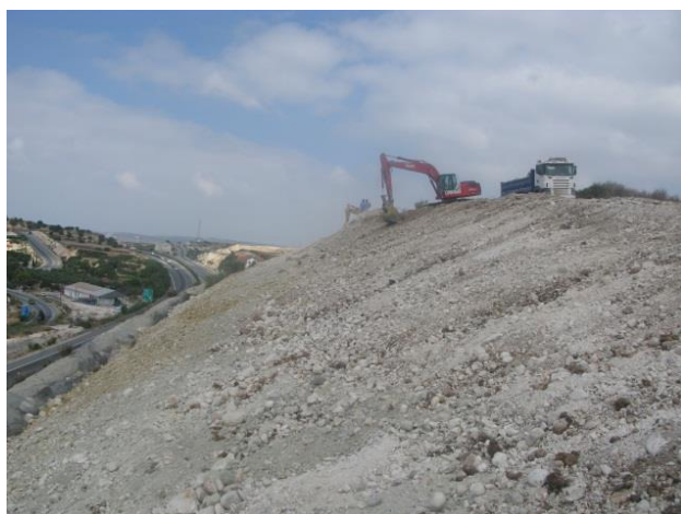
Εργασίες προσωρινής αποκατάστασης της αστάθειας στη τελευταία αναβαθμίδα του μεγάλου πρανούς παρά τη γέφυρα Πισσουρίου με βάση την εκπόνηση της γεωλογικής έρευνας από το Τμήμα Γεωλογικής Επισκόπησης Temporary remedial works at the big slope of the Highway near Pissouri bridge. The geological studies will continue on to the next highway slope.
