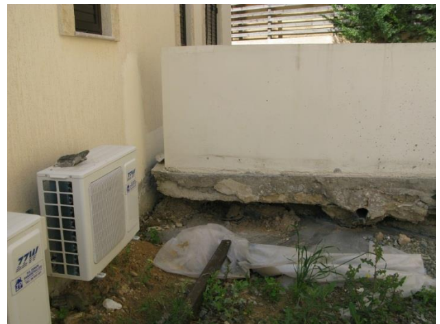
Μεγάλης έκτασης εδαφική καθίζηση στη περιοχή «Λίμνες» της κοινότητας Πισσουρίου Large scale appearances of the soil instability in the "Limnes" area of Pissouri community
