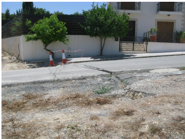
Μεγάλης έκτασης εδαφική καθίζηση στη περιοχή «Λίμνες» της κοινότητας Πισσουρίου Large scale appearances of the soil instability in the "Limnes" area of Pissouri community
