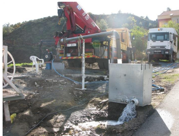
Ανόρυξη παραγωγικής γεώτρησης (αριστερά), δοκιμαστική άντληση σε γεώτρηση (δεξιά). Drilling a water supply production borehole(left) – Performing pumping test on a borehole (right).
