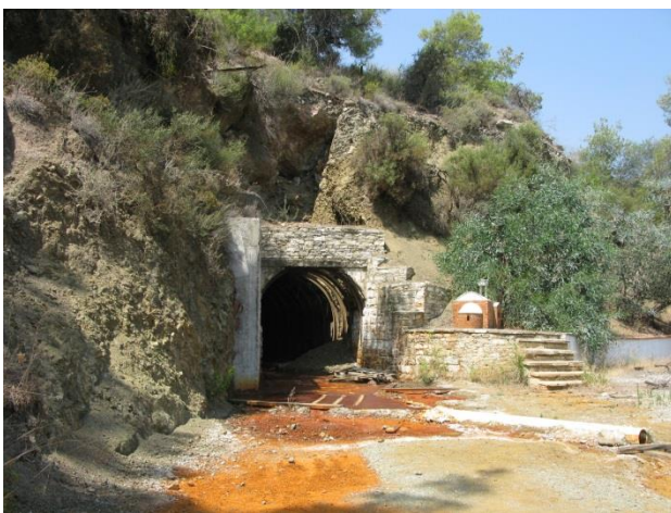
Όξινες εκροές από τη στοά του μεταλλείου της Καλαβασού Acid mine drainage from the Kalvasos mine gallery.
