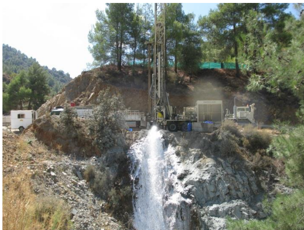
Ανόρυξη παραγωγικής γεώτρησης (αριστερά), δοκιμαστική άντληση σε γεώτρηση (δεξιά). Drilling a water supply production borehole(left) – Performing pumping test on a borehole (right).
