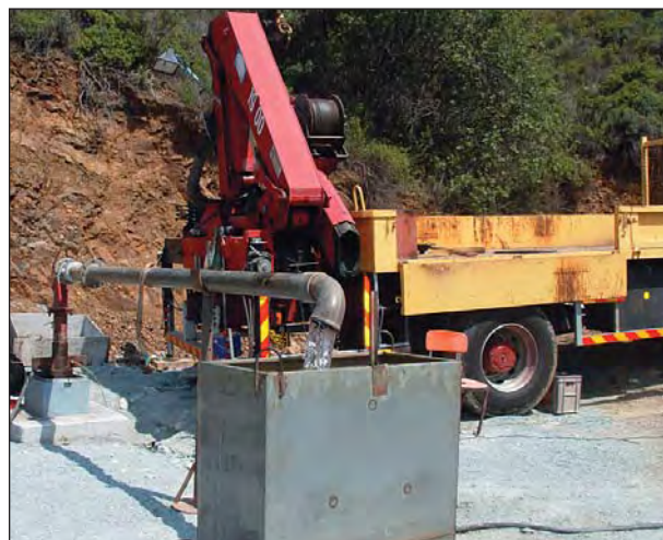
Ανόρυξη υδρογεώτρησης με σφυρογεωτρήπανο (αριστερά) – Εκτέλεση δοκιμαστικής άντλησης σε γεώτρηση (δεξιά) Drilling of a borehole with a Schramm rig (left) – Pumping test in a productive borehole in the Troodos area (right)
