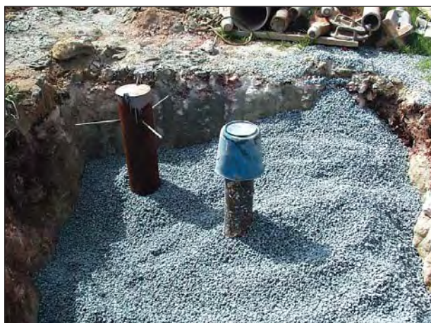
Κατασκευή εμπλουτιστικών γεωτρήσεων στα Κοκκινοχώρια (αριστερά) και στον ποταμό Γαρίλλη (δεξιά) Construction of recharge boreholes in the Kokkinochoria area (left) and Garillia river (right)
