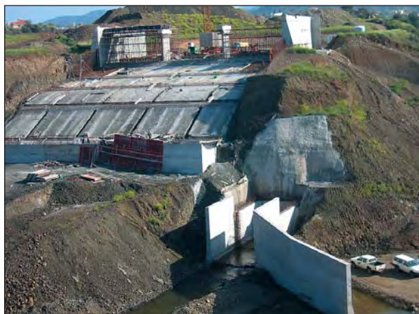
Φράγμα Ακακίου-Μαλούντας: Κατασκευή υπερχειλιστή (αριστερά) – Παρακαμπτήριος δρόμος Λεμεσού: Κατασκευή κόμβου Αγ. Αθανασίου (δεξιά) Akaki-Malounda Dam: Construction of spillway (left) – Limassol Highway Ayios Athanasios underpass junction (right)
