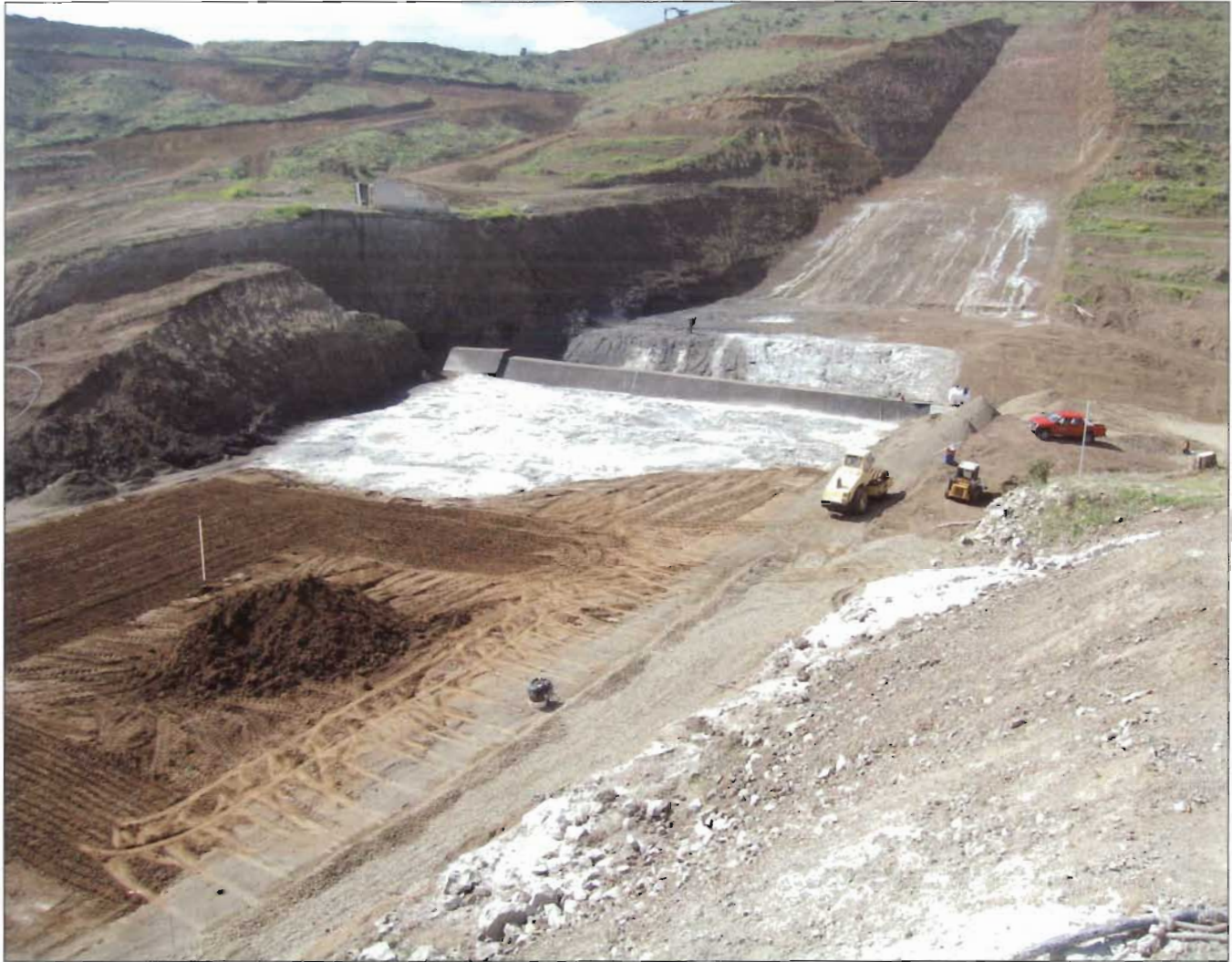
Εικ. 11: Διάστρωση αργιλικού πυρήνα στον άξονα του φράγματος Σολέας.
