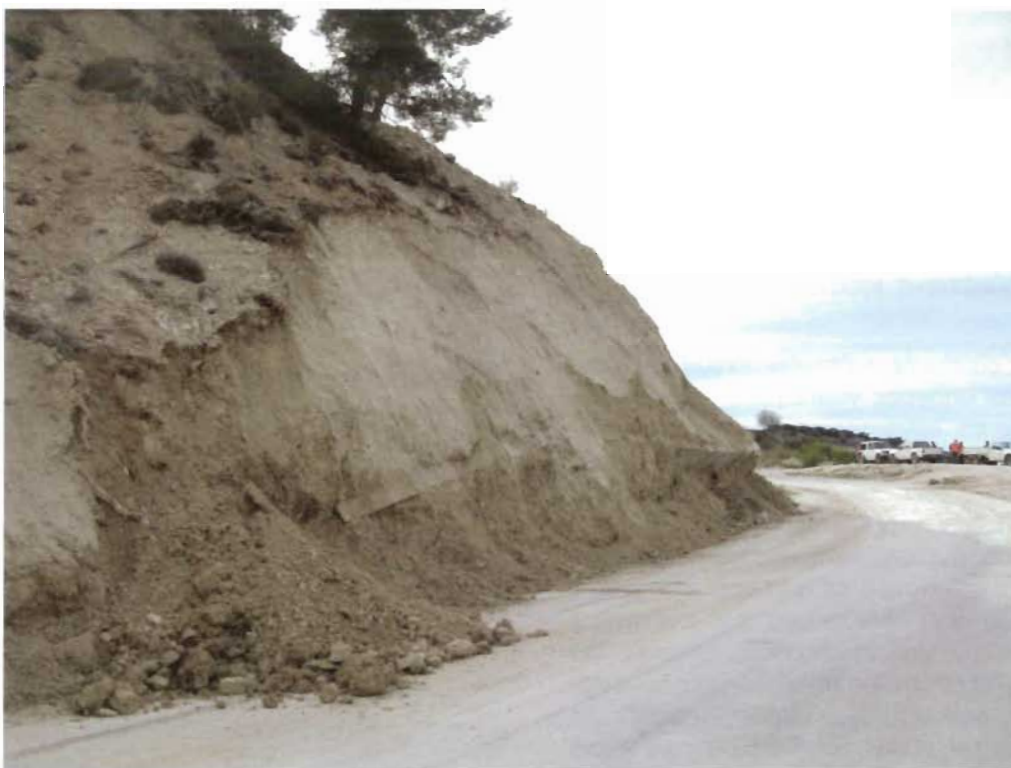
Εικ. 14: Κατολίθηση στον δρόμο Στατού – Παναγιάς. Fig. 14: Landslide at Statos – Panayia road.
