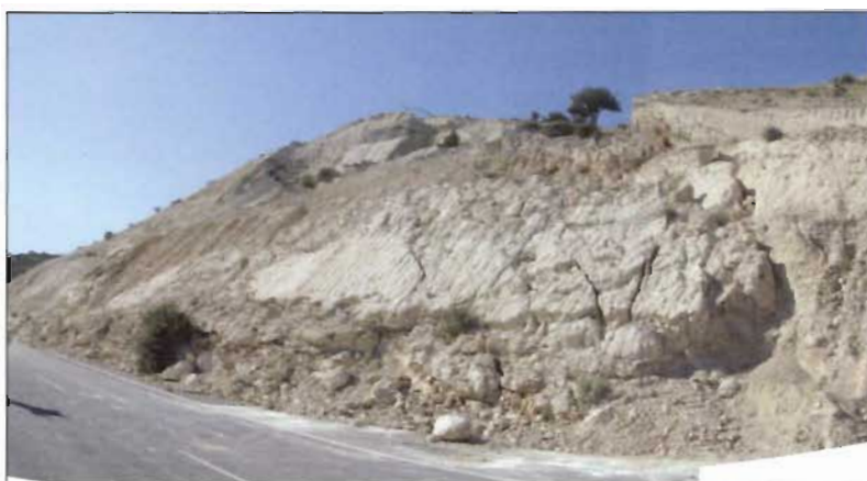
Εικ. 17: Κατολίθηση στον αυτοκινητόδρομο Πάφου – Λεμεσού. Fig. 17: Landslide at the Pafos-Lemesos highway.
