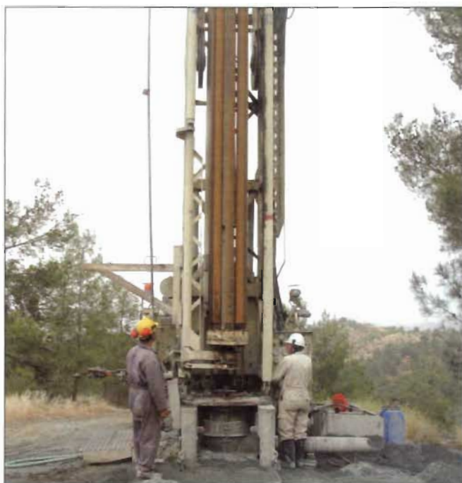
Εικ. 10: Ανόρυξη παραγωγικής γεώτρησης – Διεξαγωγή γεωφυσικών διαγραφιών σε γεώτρηση. Fig. 10: Drilling a water supply production borehole and performing geophysical logging of a borehole.
